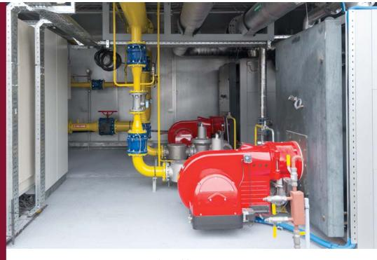
Водогрейная газовая котельная Alfa 300 смонтирована на крыше ТРЦ «Рио». Монтаж был выполнен в сжатые сроки, одновременно с монтажом инженерных коммуникаций.
