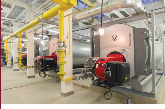
Котельная общей тепловой мощностью 12,21 МВт построена на базе трех водогрейных котлов «Valdex» производства ООО «Валдекс Теплотехника». В котельной предусмотрен учет отпущенного тепла в тепловую сеть, холодной воды на вводе в котельную, электроэнергии, коммерческий учет расхода природного газа. Предназначена для работы в автоматическом режиме без постоянного присутствия обслуживающего персонала.
