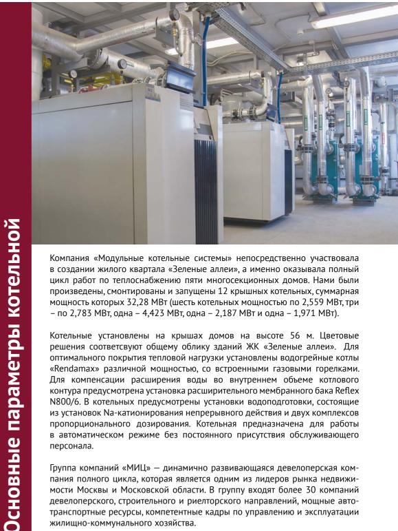
Компания «Модульные котельные системы» непосредственно участвовала в создании жилого квартала «Зеленые аллеи», а именно оказывала полный цикл работ по теплоснабжению пяти многосекционных домов. Нами были произведены, смонтированы и запущены 12 крышных котельных, суммарная мощность которых 32,28 МВт (шесть котельных мощностью по 2,559 МВт, три – по 2,783 МВт, одна – 4,423 МВт, одна – 2,187 МВт и одна – 1,971 МВт).
