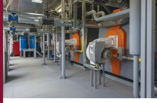
Контейнерная блочно-модульная котельная ALFA 310 предназначена для выработки тепловой энергии для отопления и горячего водоснабжения многоэтажной застройки в п. Новинки Богородского района Нижегородской об-
