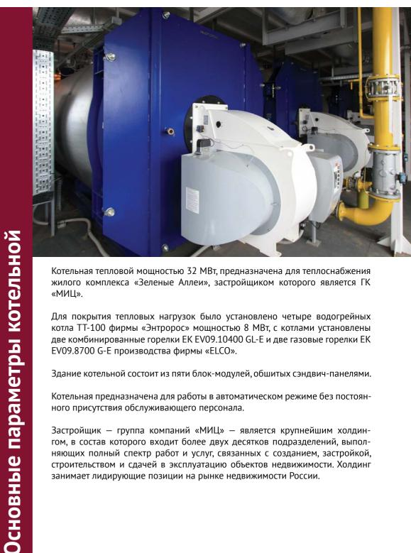
Котельная тепловой мощностью 32 МВт, предназначена для теплоснабжения жилого комплекса «Зеленые Аллеи», застройщиком которого является ГК
