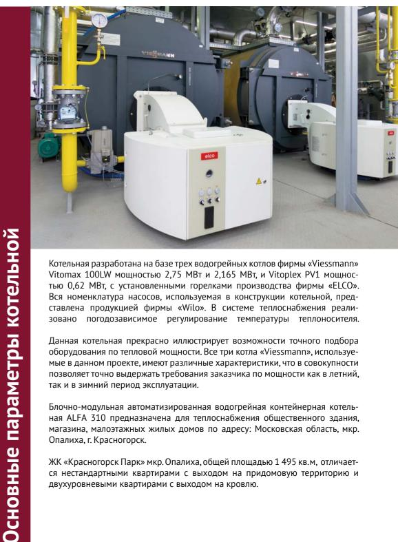
Котельная разработана на базе трех водогрейных котлов фирмы «Viessmann» Vitomax 100LW мощностью 2,75 МВт и 2,165 МВт, и Vitoplex PV1 мощностью 0,62 МВт, с установленными горелками производства фирмы «ELCO». Вся номенклатура насосов, используемая в конструкции котельной, представлена продукцией фирмы «Wilo». В системе теплоснабжения реализовано погодозависимое регулирование температуры теплоносителя.
