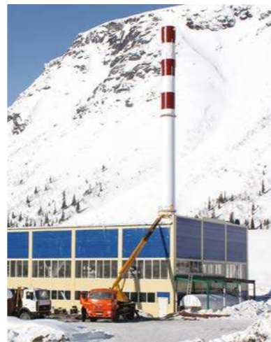
Завершено строительство крупнейшего на сегодня объекта «МКС» г. Апатиты, котельная 80 т пара/ч
