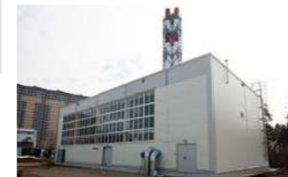
Заключен договор на Стационарную котельную в строящемся ЖК «Новоград «Павлино» – первую в России, в которой применена система рециркуляции газов
