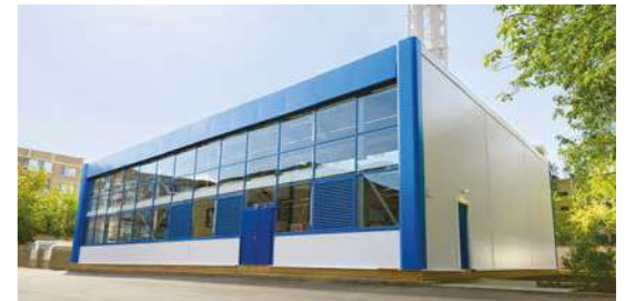
Реализован проект самой крупной модульной котельной на территории РФ г. Домодедово, котельная 52,33 MWt
