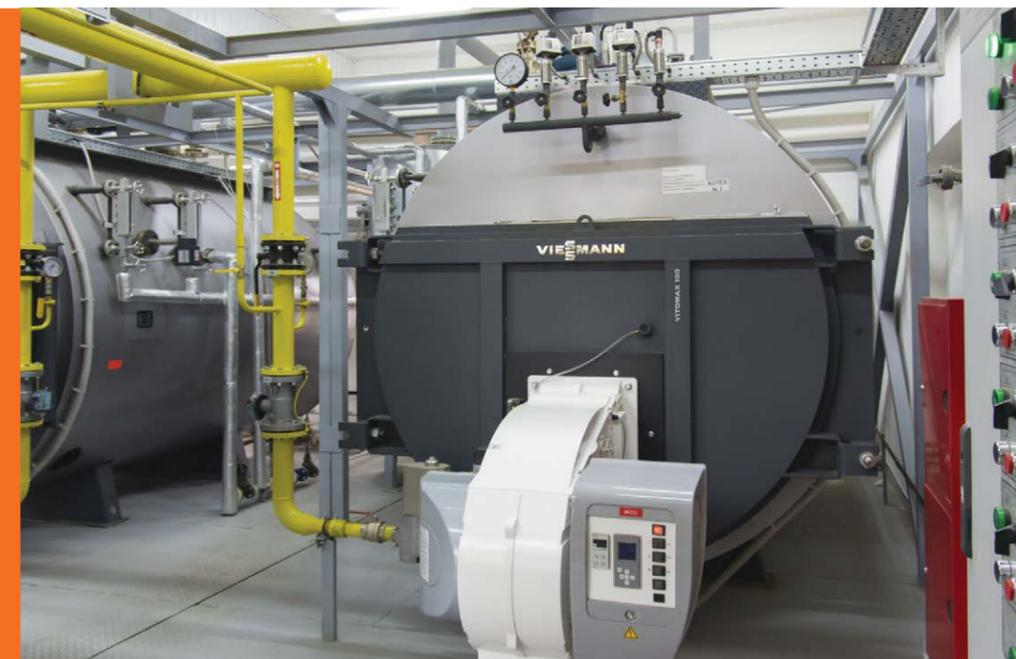
Встроенная котельная (на рамах) предназначена для технологических нужд, отопления и горячего водоснабжения кондитерской фабрики ОАО «Виктория», паропроизводительностью 8,8 т/ч. Наша компания осуществила реконструкцию и техническое перевооружение уже существующей котельной.
