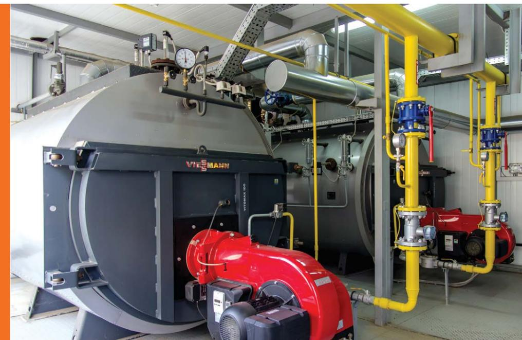
Автоматизированная блочно-модульная котельная паропроизводительностью 5,4 т/ч для комбикормового завода производительностью 30 тонн/час со складом хранения зерна 50 000 тонн. Котельная предназначена для технологических нужд, отопления и горячего водоснабжения одного из крупнейших в стране предприятий по производству и переработке индейки ГК «Дамате» (ТМ «Индилайт»).
