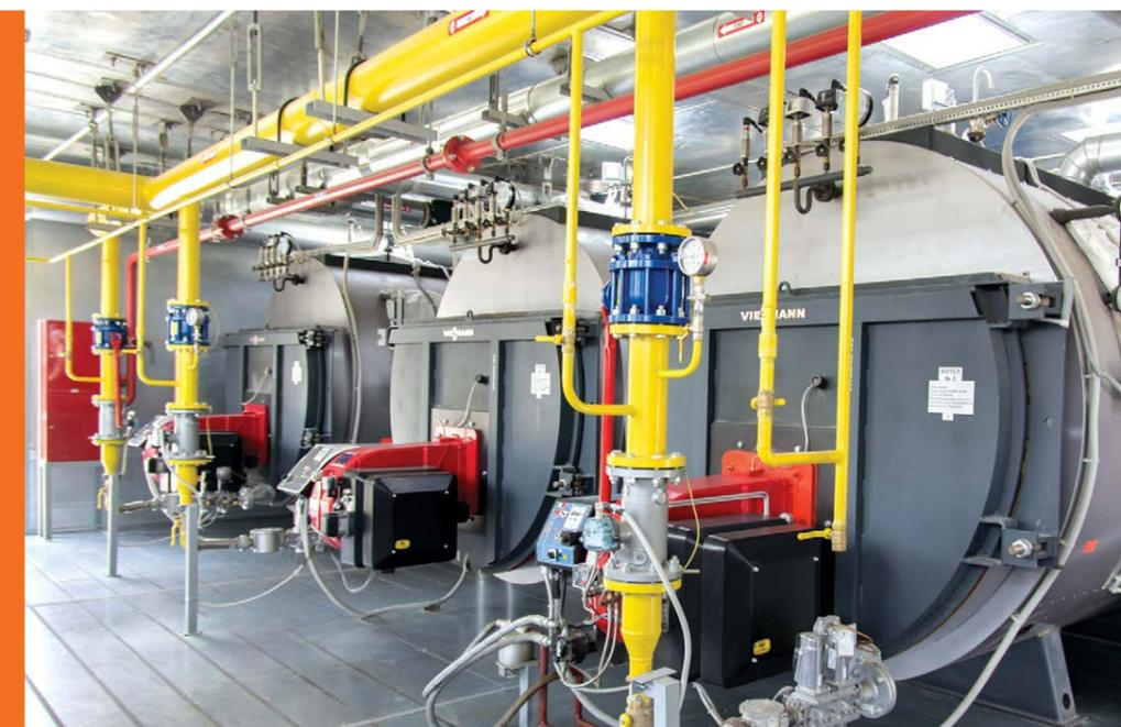
У компании «МКС» есть выполненные объекты, территориально расположенные за границами Российской Федерации. Так, паровая контейнерная котельная ALFA 350, паропроизводительностью 19,2 т/ч, предназначена для обеспечения технологическим паром, теплом и водоснабжением производственной базы заказчика, расположенной в Республике Казахстан, г. Алматы.
