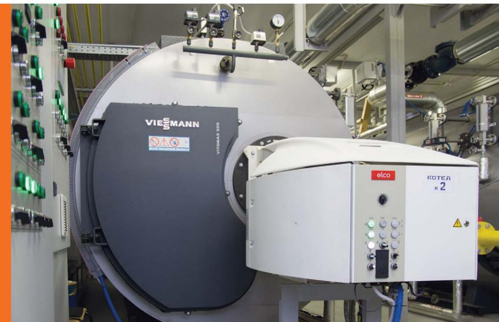
Блочно-модульная котельная паропроизводительностью 8 т/ч предназначена для технологических нужд, отопления и горячего водоснабжения производственной базы по выпуску продуктов питания ООО «Камский Бекон».
