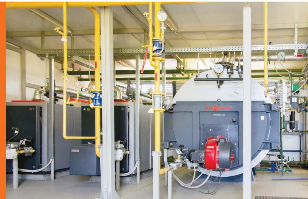
Блочно-модульная котельная паропроизводительностью 1,3 т/ч и тепловой мощностью 0,8 МВт для нужд комбикормового завода.
