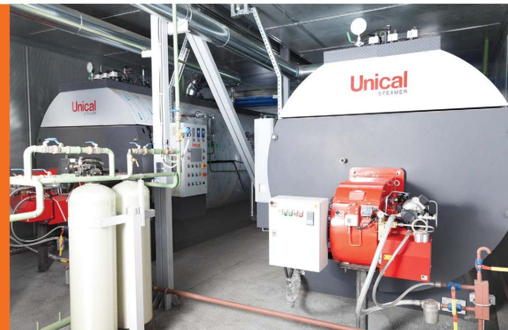
Модульная котельная паропроизводительностью 10 т/ч произведена для цеха взрывных работ на промплощадке Восточного рудника ОАО «Апатит». Котельная обеспечивает технологическим паром стационарный пункт по производству невзрывчатых компонентов эмульсионных взрывчатых веществ.
