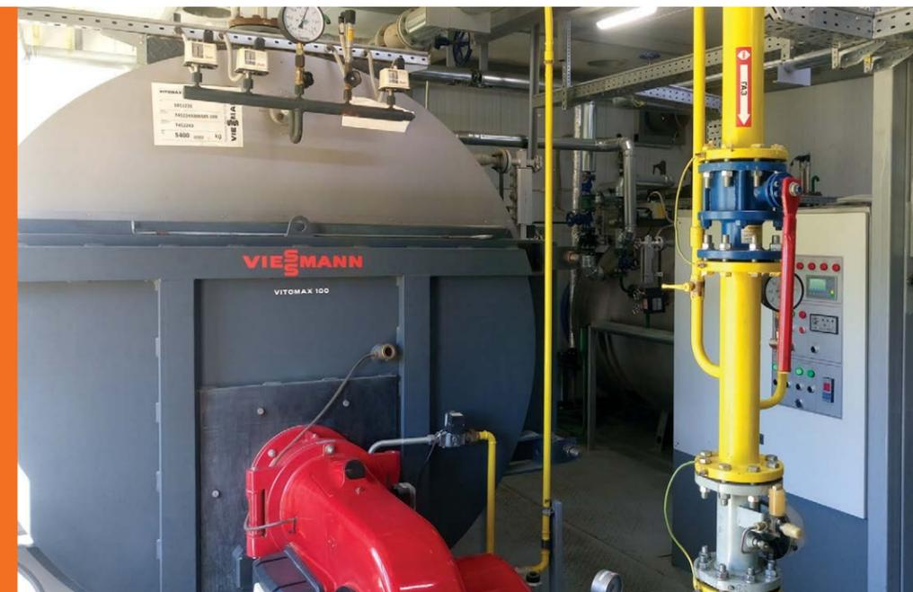
Автоматизированная блочно-модульная паровая котельная, паропроизводительностью 4,5 т/ч, предназначена для пароснабжения, теплоснабжения, вентиляции и снабжения горячей водой одного из цехов мясоперерабатывающего завода ООО «Гагарин-Останкино».
