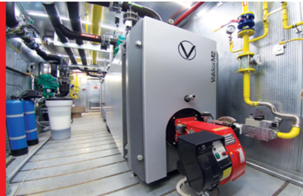
Блочно-модульная котельная тепловой мощностью 1,56 МВт предназначена для теплоснабжения комплекса канализационных очистных сооружений. Котельная выполнена в оригинальных цветах, повторяющих цветовое решение всего комплекса.
