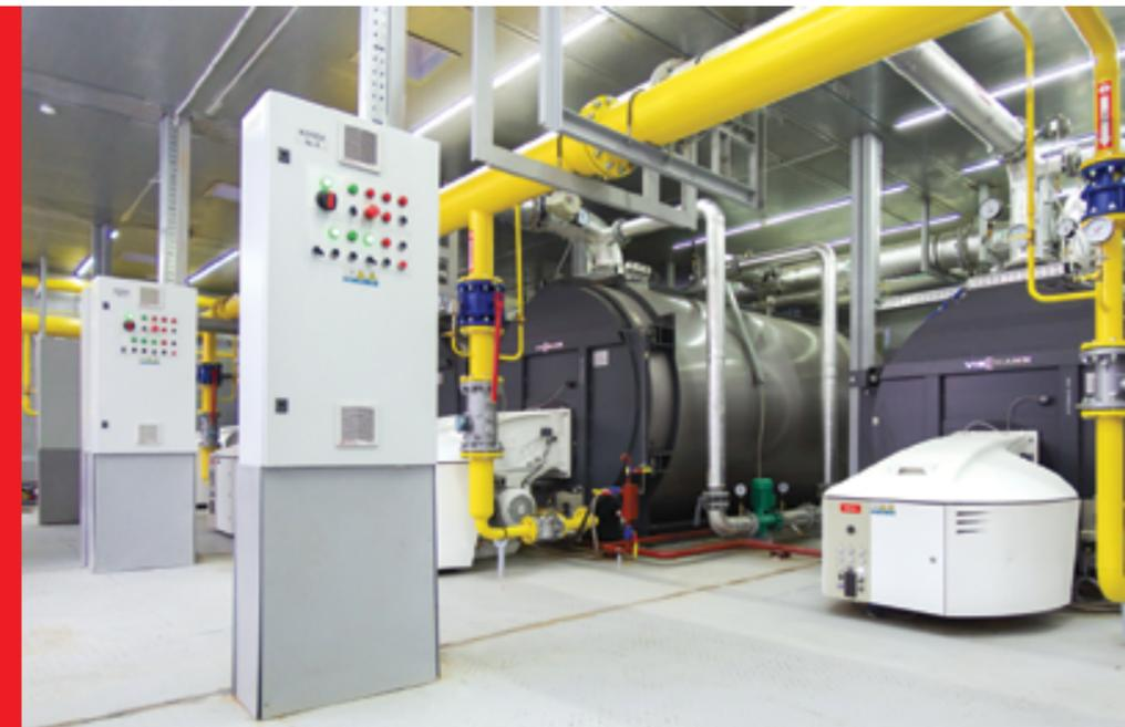
Котельная спроектирована на базе трех водогрейных котлов Vitomax 100 LW фирмы «Viessmann» мощностью 5 МВт и одного водогрейного котла Vitomax 100 LW фирмы «Viessmann» мощностью 2,9 МВт. В качестве аварийного топлива может быть использовано дизельное топливо.
