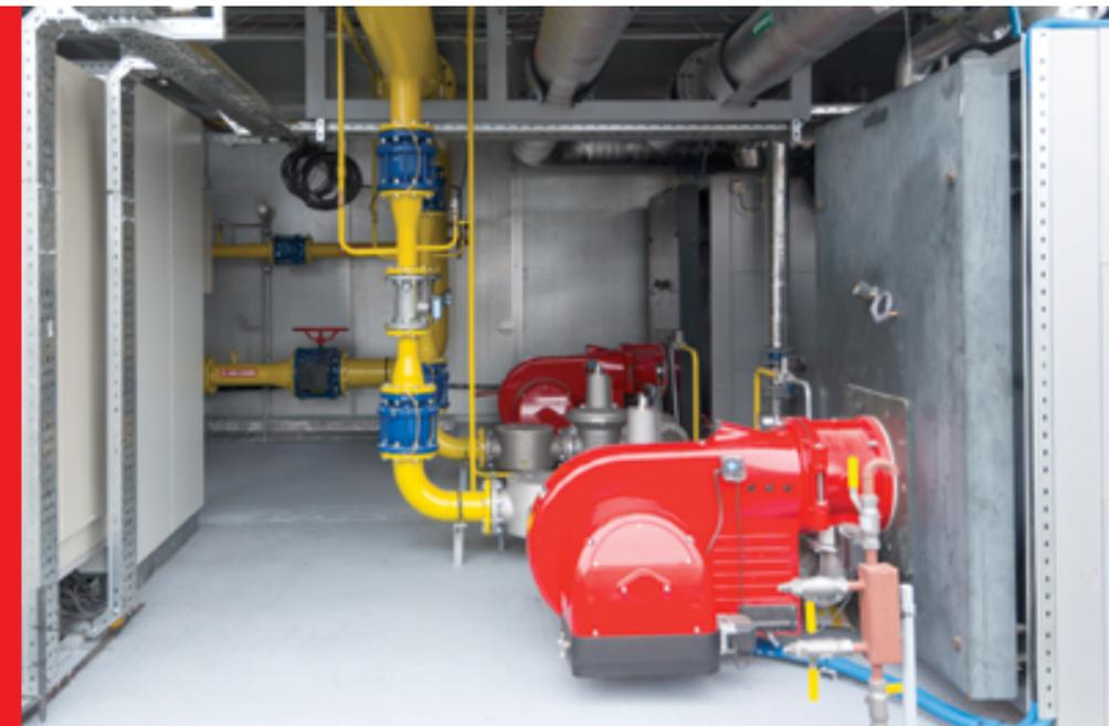
Водогрейная газовая котельная Alfa 300 смонтирована на крыше ТРЦ «Рио». Монтаж был выполнен в сжатые сроки, одновременно с монтажом инженерных коммуникаций.
