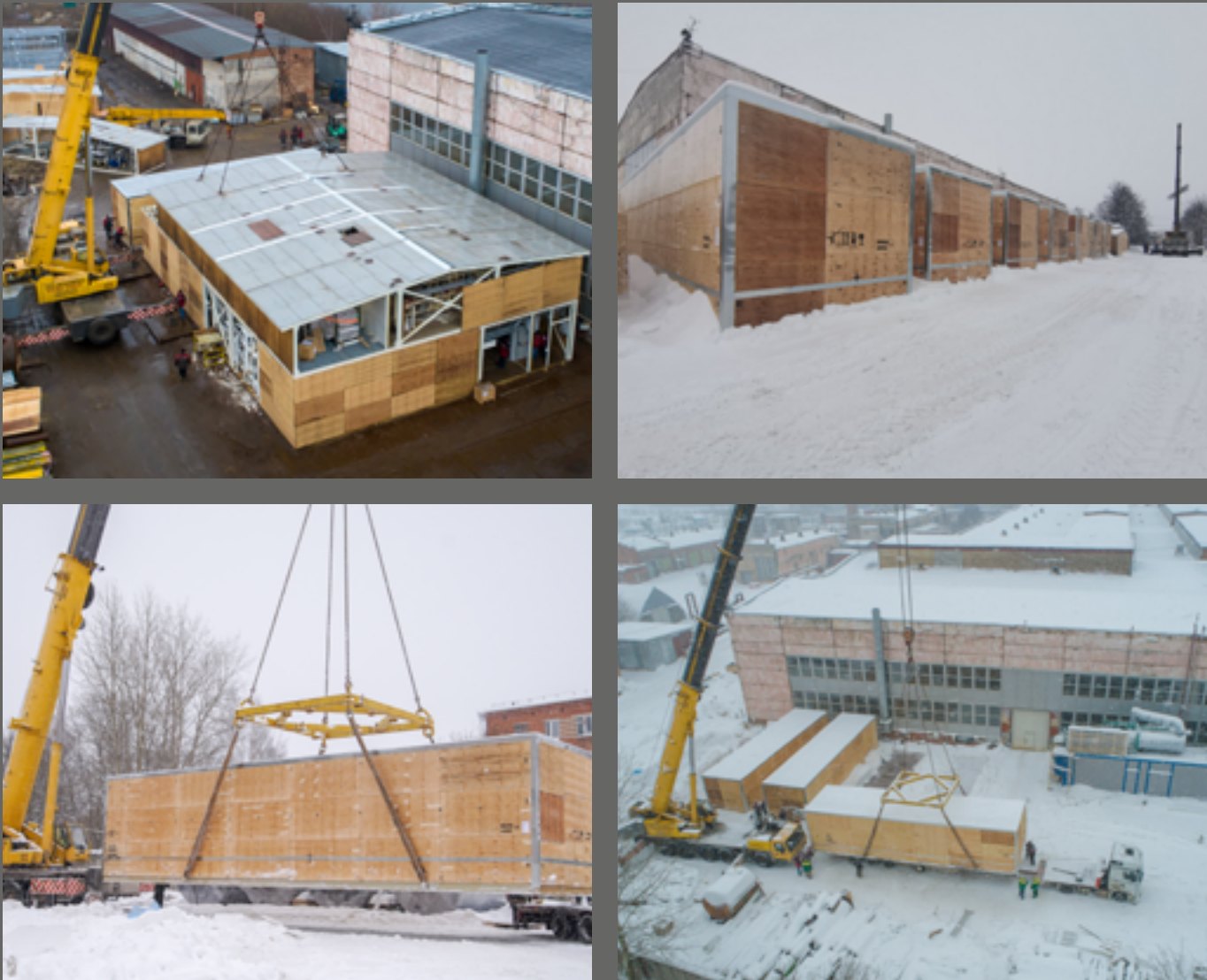
Отгрузка котельной производилась в 3 этапа. Предварительно на заводе выполнены контрольная сборка и раздвижка блок-модулей. Контрольная сборка позволяет достичь наибольшей точности сборки на площадке монтажа.
