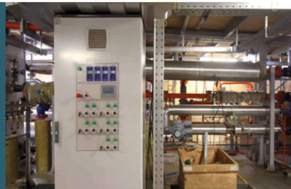
Модульная паровая котельная 36 т/ч для ООО «РН-Сахалинморнефтегаз». Котельная состоит из шестнадцати модулей. Параметры пара паропроизводительностью 36 т/ч, с давлением от 0,2 до 2,1 МПа, температурой до 330°C вырабатываются паровыми котлами с пароперегревателями производства фирмы «Astebo» с автоматическим регулированием параметров.
