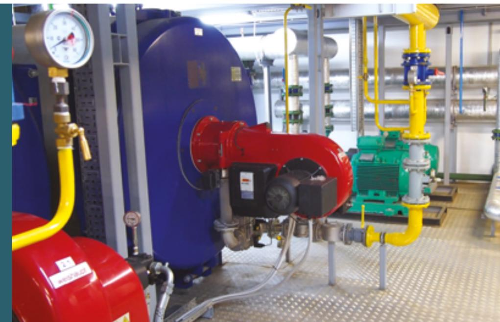
Котельная спроектирована на базе пяти котлов производства фирмы «Энтророс». Здание котельной с пристроенным к нему складом аварийного топлива выполнено в виде единого отдельно стоящего архитектурного комплекса с плоской кровлей.
