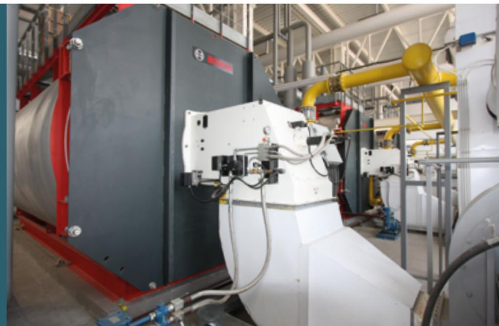
Водогрейная котельная мощностью 49,2 МВт предназначена для теплоснабжения жилого комплекса «Новоград Павлино» в г. Балашиха Московской области. Котельная представляет собой прямоугольное строение размером 16x28 м, выполненное на металлическом каркасе с навесными стеновыми сэндвич-панелями. На плоской кровле организован внутренний водосток, пол сделан из керамической плитки.
