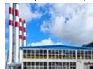
Запуск БМК, 88 МВт Дальневосточный ФО, Амурский газоперерабатывающий завод
