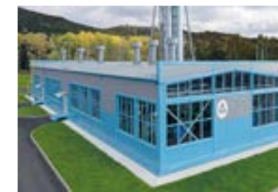
Запуск БМК, 60 МВт Южно-Сахалинск, ООО «РИР-Сахалин»
