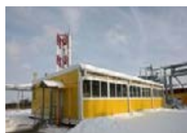
Изготовлена блочно-модульная котельная для завода «Гагарин Останкино» г. Гагарин, котельная 25,6 т/ч
