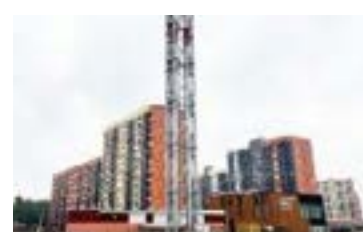
Изготовлена водогрейная блочно-модульная котельная г. Москва, ЖК Кленовые аллеи, котельная 23,1 МВт
