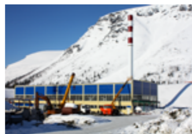
Завершено строительство крупного объекта «МКС» г. Апатиты, котельная 80 т пара/ч
