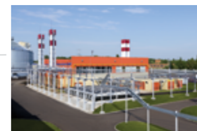
Запущен энергоцентр для одного из крупнейших агрохолдингов г. Ишим, энергоцентр 67, 64 т/ч, 52,33 МВт
