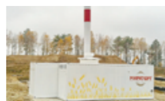
Изготовлена 100-я котельная АПХ «Мираторг»
