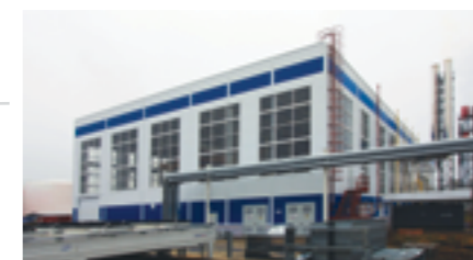
Строительство крупного энергоблока энергоцентр для ООО «Ангел Ист Рус», 83 т/ч, 16,78 МВт
