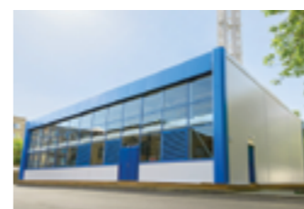
Реализован проект самой крупной модульной котельной на территории РФ г. Домодедово, котельная 52,33 МВт
