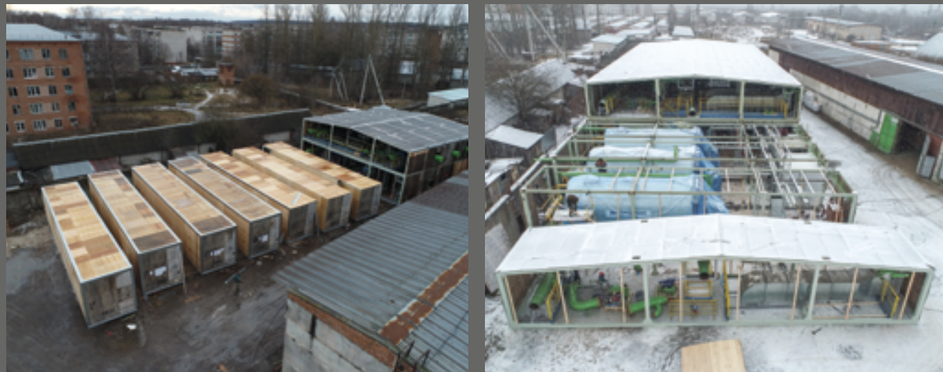
Отгрузка производилась автомобильным транспортом с производственной площадки в Ставрово до г. Благовещенска. Предварительно была проведена разгрузка и раздвижка модулей.
